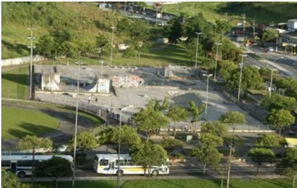
Figura 14: Pista do Paço depois da construção do half pipe
