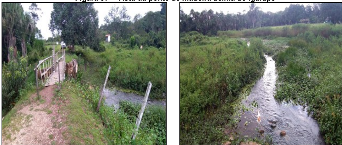
Figura 37 – Vista da ponte de madeira acima do igarapé
