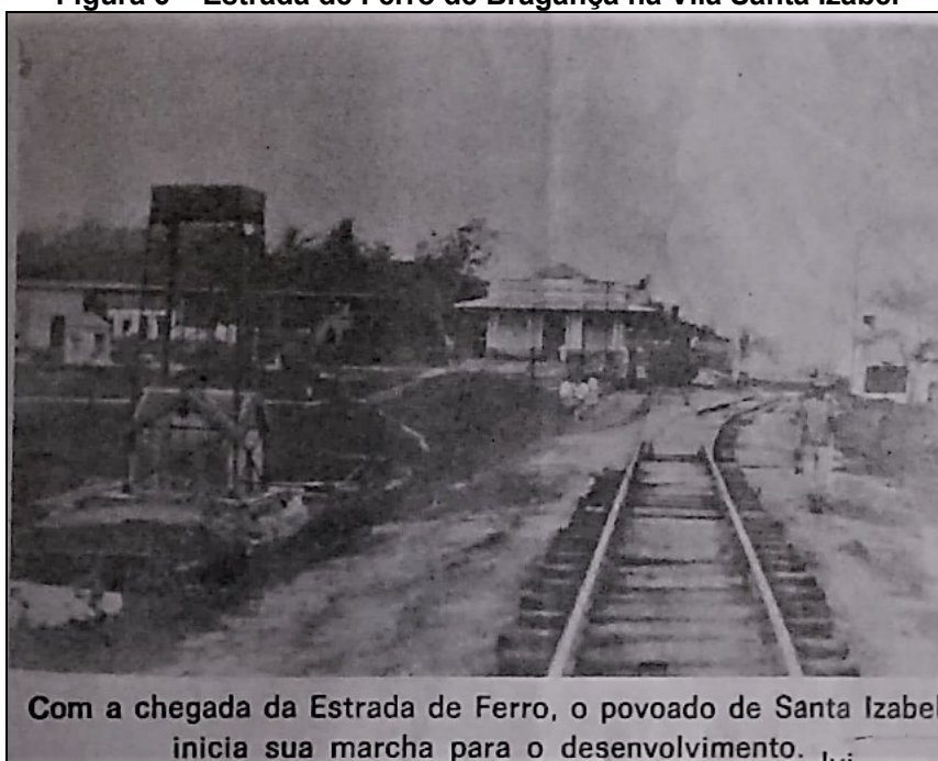
Figura 6 – Estrada de Ferro de Bragança na Vila Santa Izabel
