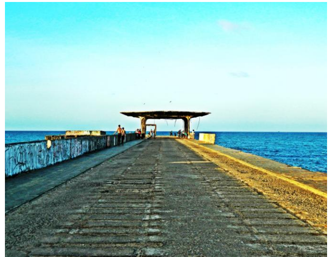
Foto 3 – Fortaleza em forma de dicotomia 2 – Ponte do Poço da Draga
