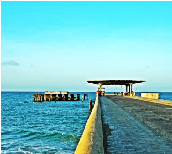
Foto 2 – Fortaleza em forma de dicotomia 1 – Ponte do Poço da Draga
